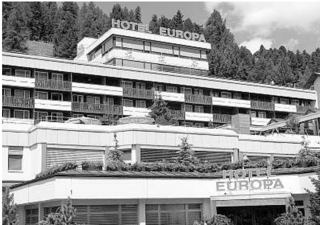
Neues Solarkonzept entwickelt und umgesetzt: Das Hotel «Europa» in Champfèr setzt auf ökologische Nachhaltigkeit.
